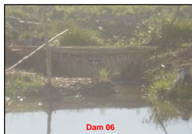
Dam 06 Kalampangan kanal
