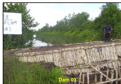
Dam 03 Kalampangan kanal
