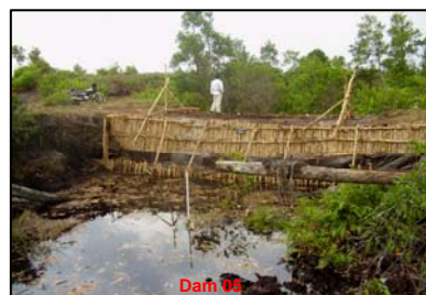
Dam 05 Kalampangan kanal
