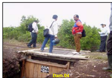
Dam 04 Kalampangan kanal
